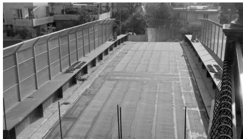
Il ponte di via Semmola
